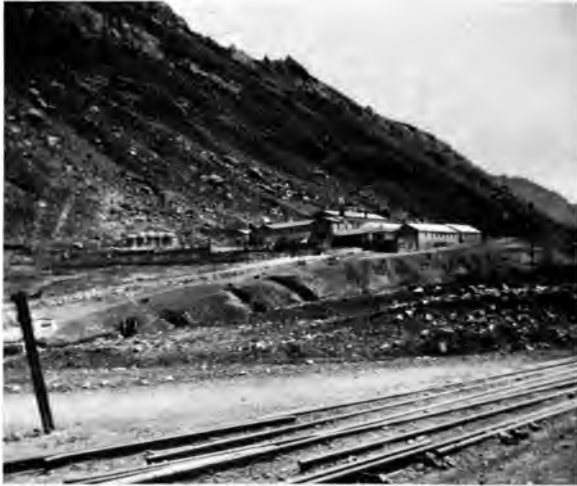
PUENTA DEL INCA, ARGENTINA
